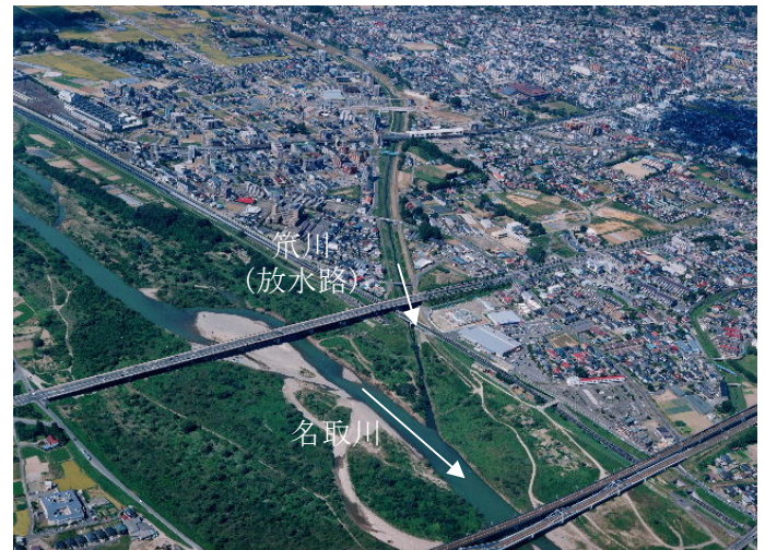
▲ 策川放水路 改修延長＝2,850m 着手：昭和 43 年 完成：昭和 53 年 【出典：仙台河川国道事務所資料】
