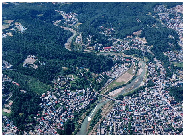
▲瀬淵が連続し、グラウンド整備された広瀬川中流部の状況 【出典：仙台河川国道事務所資料】
