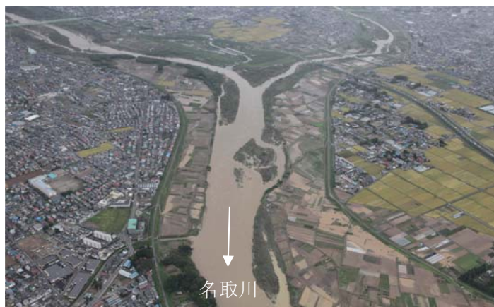
▲平成 23 年 9 月洪水 (名取川と広瀬川の合流点付近) 【出典：仙台河川国道事務所資料】
