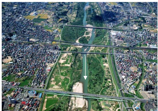
▲名取川 8.0km～9.0km 付近の状況
