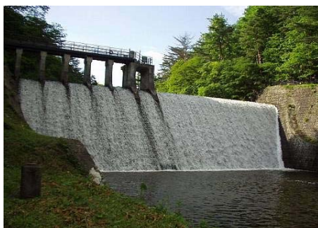
▲青下第二ダム
