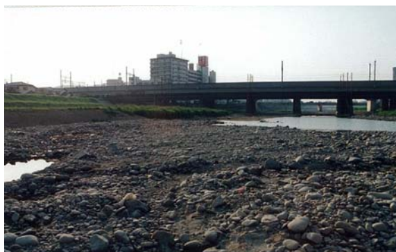
▲平成6年渇水時写真(広瀬川)
