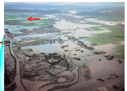
S61.8 仙台空港周辺の浸水状況(岩沼市)
