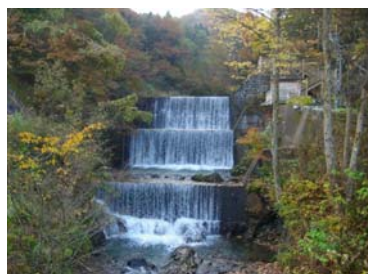
東鴉川第一砂防堰堤
