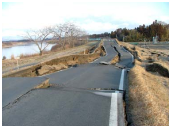
阿武隈川右岸 22.0k 付近 (角田市坂津田地先) ※地震による堤防沈下
