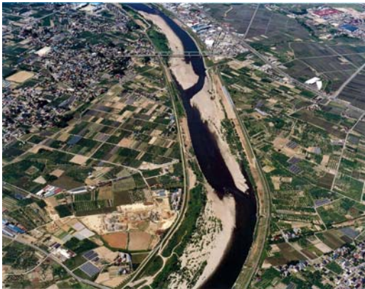
福島盆地を流れる区間では、高水敷の整備がなされ、帰化植物の形成が多く見られる
