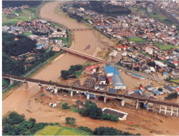
8 月 27 日に氾濫、30 日に決壊した支川 堀川が合流する白河市の状況
