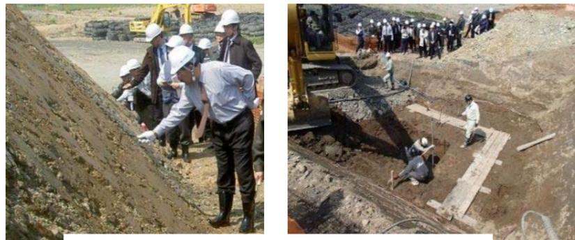
堤防断面の土質確認と基礎地盤の開削調査
