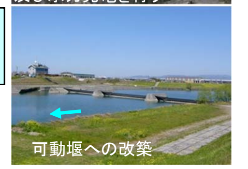
洪水調節、かんがい用水補給及び水力発電を行う
