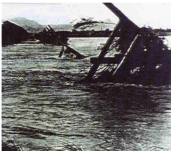
流出した高松橋 (宮崎市)
