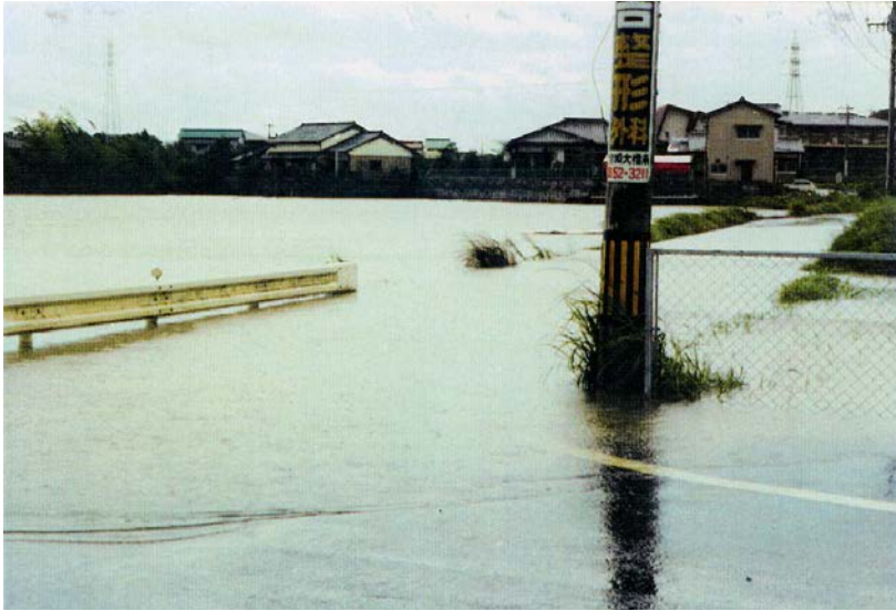
下小松地区 (8/000右岸付近) 浸水状況
