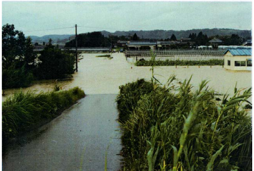
下小松地区 (8/000右岸付近) 浸水状況
