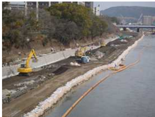
【仮締切り内のドライ施工状況の例】
