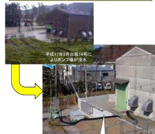
防水壁の設置 (飯田川排水ポンプ場)
