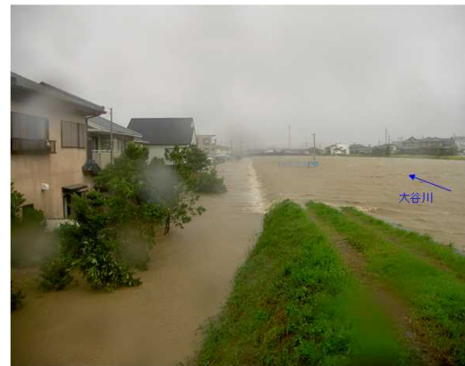
【平成17年9月洪水堤防溢水状況(大谷川左岸堤防)】
