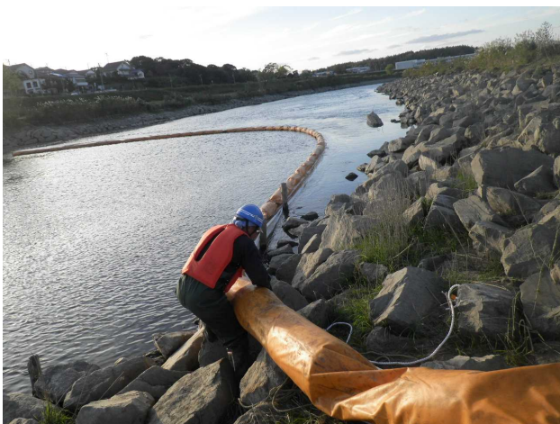
【汚濁防止フェンス設置状況の例】
