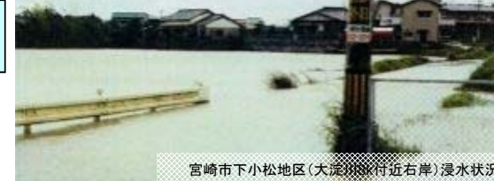
宮崎市下小松地区(大淀川3k付近右岸)の浸水状況
