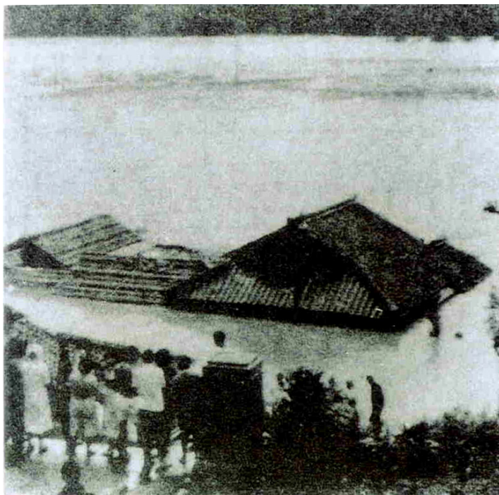
軒先まで浸水した家 (宮崎市高岡町)
