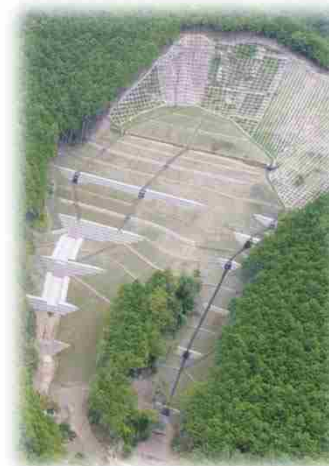
(写真左)山腹工 (写真右)溪間工の施工地。
