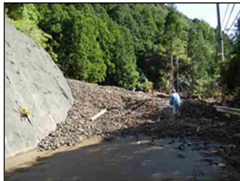
国道425号線の土砂流出状況
