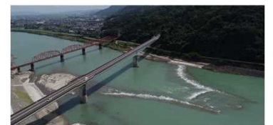
下流域(八の字堰)
