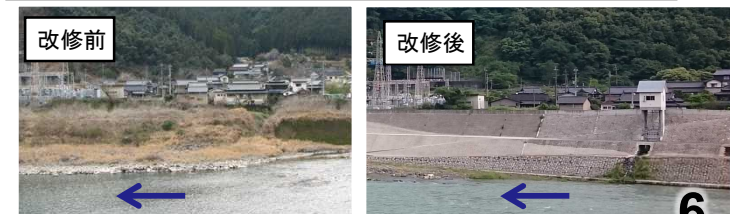
かさ上げ実施事例(八代市坂本町藤本地区)
