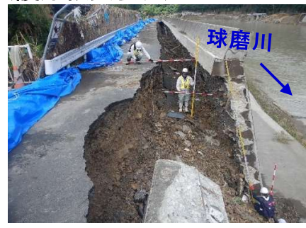
(護岸被災状況)
