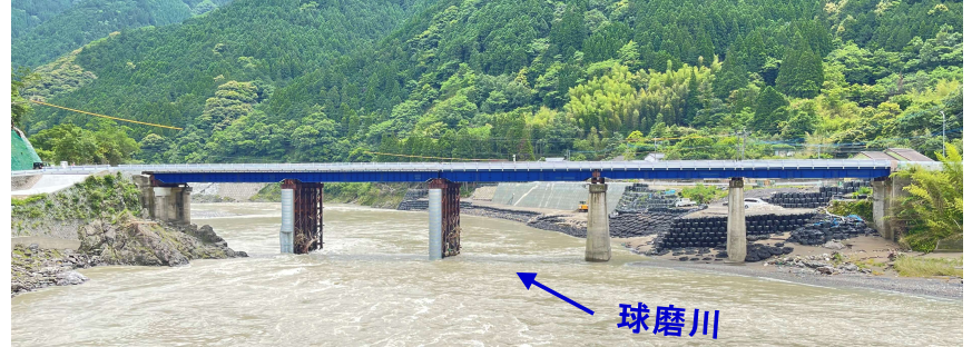
【仮橋が開通した鎌瀬橋(国道219号)】
