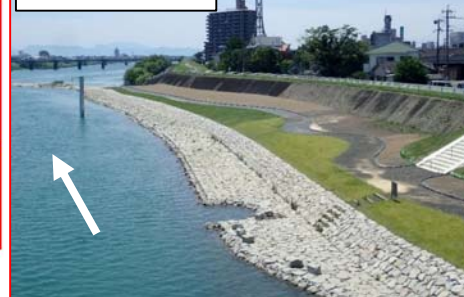
堤防補強状況 (R2. 6)
