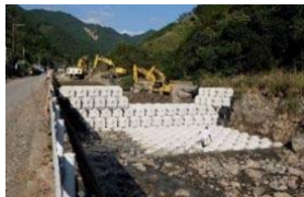
【仮設土砂止め】
