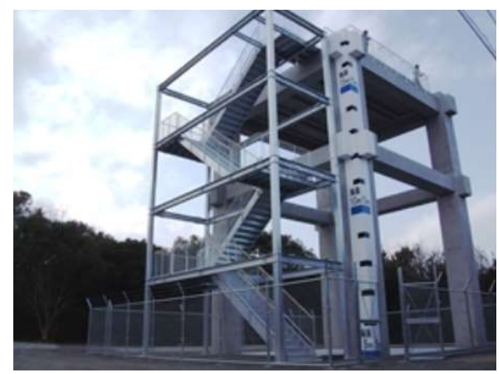
＜旭化成新港基地(株)が整備した津波避難タワー＞
