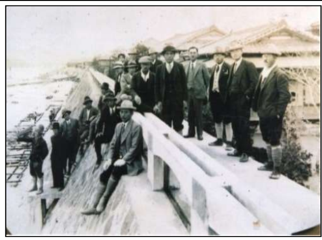
大正末期から昭和初期に竣工
