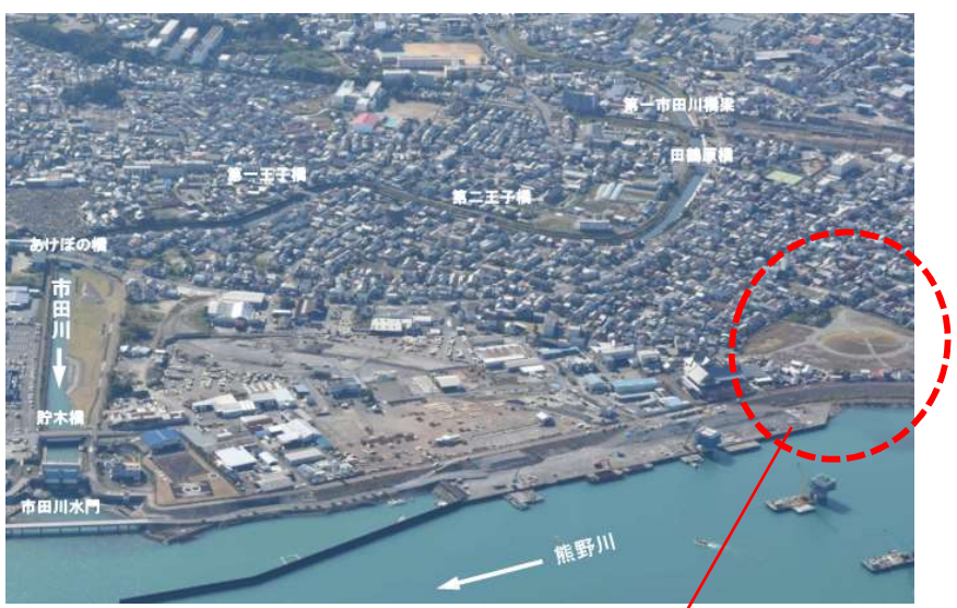
【新宮市蓬萊地区】宮井戸津波避難地
