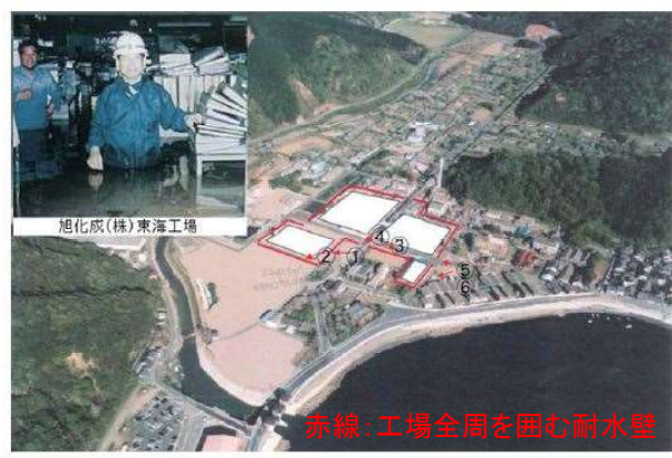
＜旭化成(株)東海工場の耐水壁と平成9年の浸水状況＞
