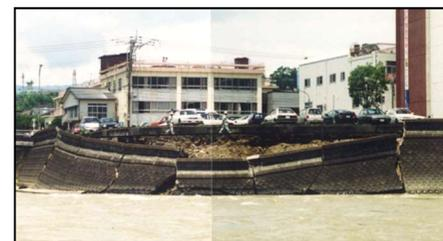
基礎洗掘により護岸が崩壊した事例
