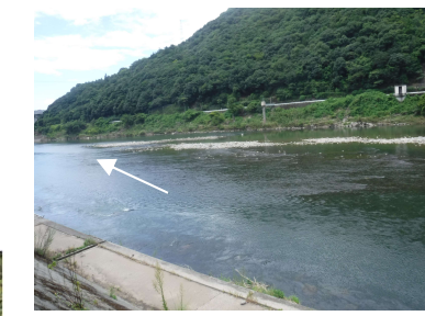
下流側の状況 (R3. 8撮影)
