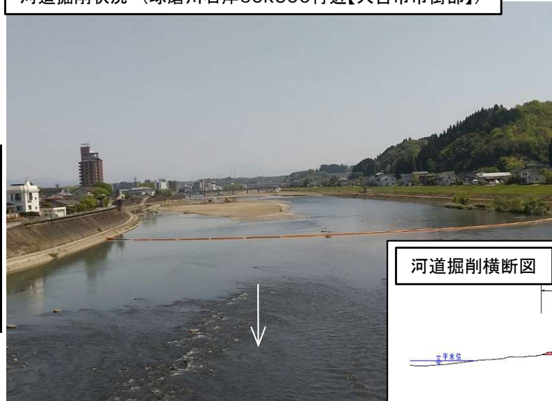
河道掘削状況 (球磨川右岸60k300付近【人吉市市街部】)
