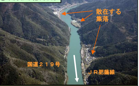
○約43kmの長区間にわたる山間狭窄部 ○河床勾配：約1/300～1/1,000
