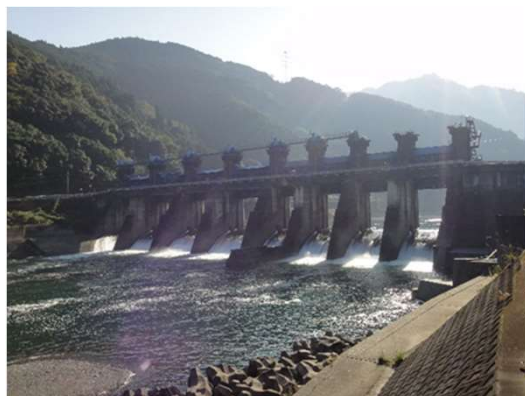
荒瀬ダム（平成30年3月撤去）
