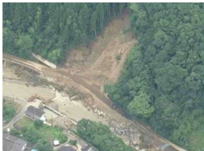
【R2年7月豪雨時の球磨川中流部支川小川における山腹崩壊状況】
