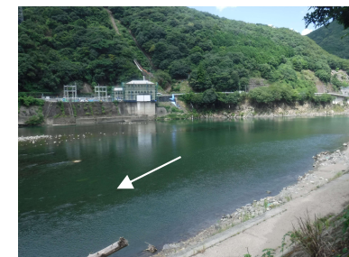
上流側の状況 (R3. 8撮影)
