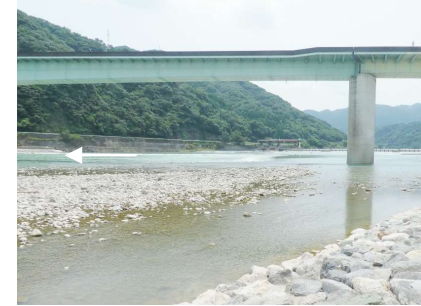
左岸土砂堆積状況 (R2. 8撮影)
