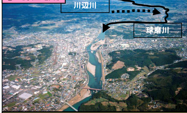
○本川とほぼ同規模の流域面積を持つ最大支川川辺川が合流 ○河床勾配：1/500～1/700
