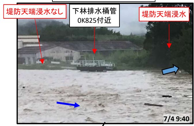
万江川(下林排水樋管(左岸))
