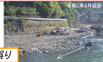
河道掘削状況及び掘削断面(球磨川右岸47k6付近)
