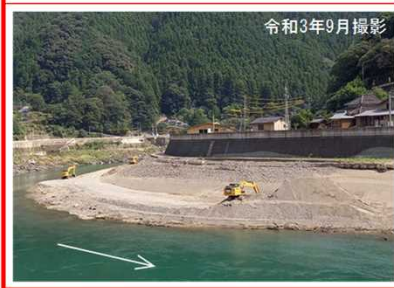
河道掘削状況及び掘削断面(球磨川右岸25k0付近)
