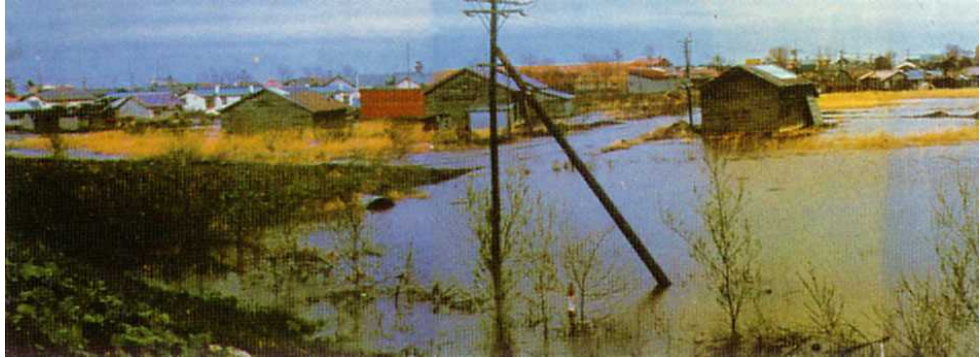
写真 4-2 十勝川右岸 大津築堤の内水氾濫（豊頃町）
