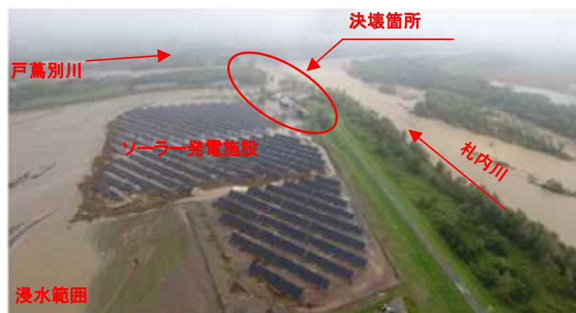
写真 4-6 札内川 戸蔭別川合流付近の決壊後の状況（帯広市）
