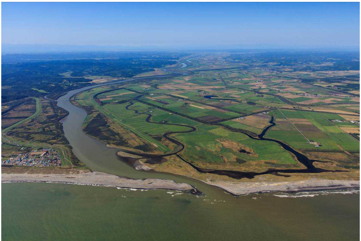
写真 2-13 十勝川下流 河口付近 (令和2年9月撮影)
