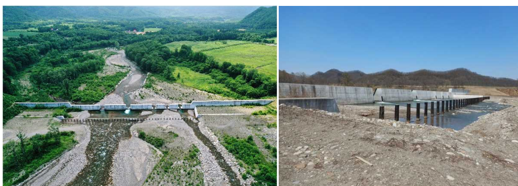
図 2-43 戸蔭別川第 2 号砂防堰堤（完成）
