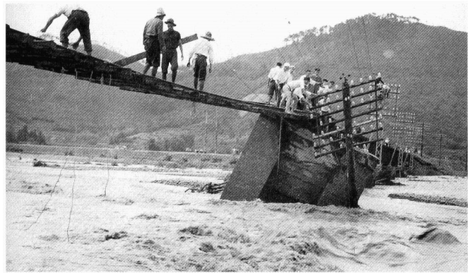
流失寸前の電車の鉄橋（路面電車 福島・長岡（伊達市）間の松川鉄橋）
