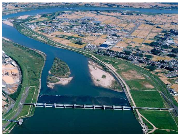
代表的な河川構造物 阿武隈大堰
