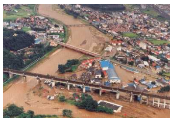
H10.8 洪水 8月27日に氾濫し、30日に決壊した 支川 堀川が合流する白河市
