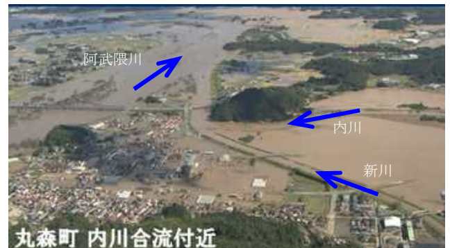
宮城県丸森町付近の出水状況
