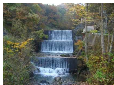
東鴉川第一砂防堰堤
