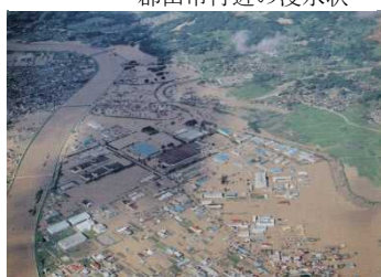
S61.8 支川 谷田川の決壊と 郡山市付近の浸水状
