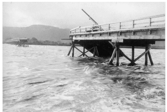
福島県桑折町伊達崎橋流失状況
