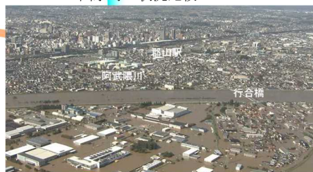
R01.10 福島県郡山市 郡山中央工業団地の浸水状況
