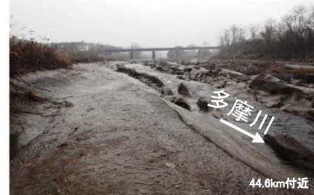
土丹が露出し、河床低下が進行。
