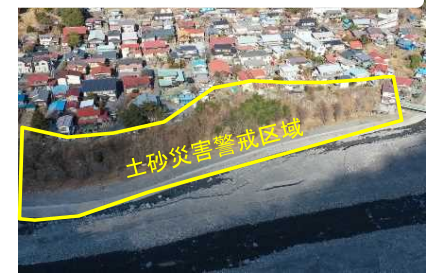
急傾斜地崩壊対策 中宿地区(丹波山村丹波)
