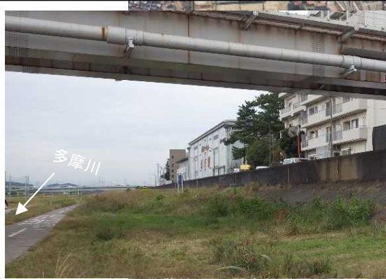
■ 左岸側の堤防はパラペット構造であり、堤防整備が必要
