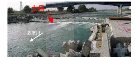
平成13年9月洪水による被災状況
