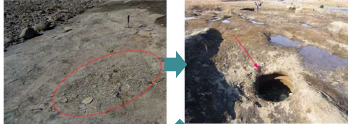
風化による表面の剥離
