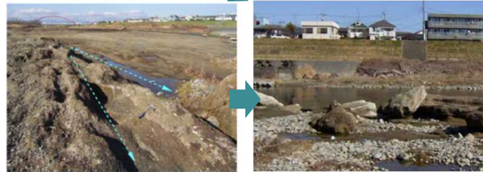
縦断方向に溝状侵食を形成
