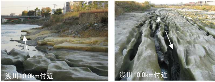
浅川10.0km付近 砂礫層が流出し、土丹が露出
