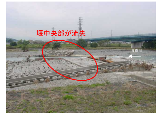
平成13年9月洪水による被災状況
