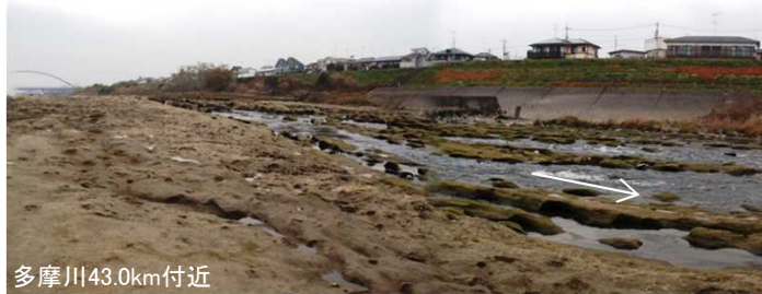
多摩川43.0km付近 土丹の露出状況
