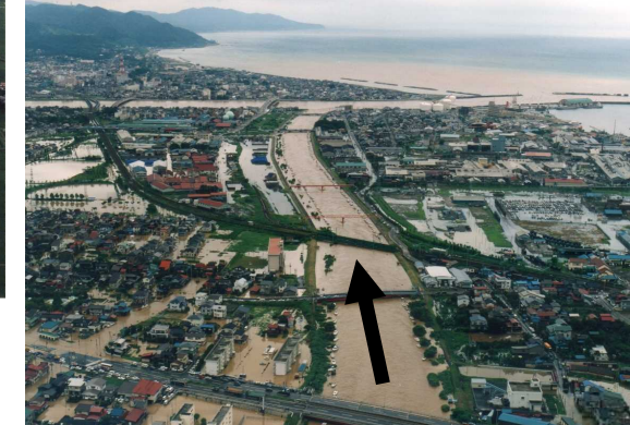
上越市 保倉川の溢水(越水)氾濫
