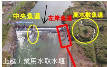
【上越工業用水取水堰(7.6k) 魚道状況】
