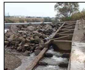
【上越工業用水堰（7.6k）の魚道改良】 （魚道の機能維持）
