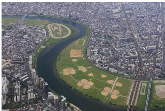
写真 8-6 下流部 7.0k付近（蛇行した河道）
