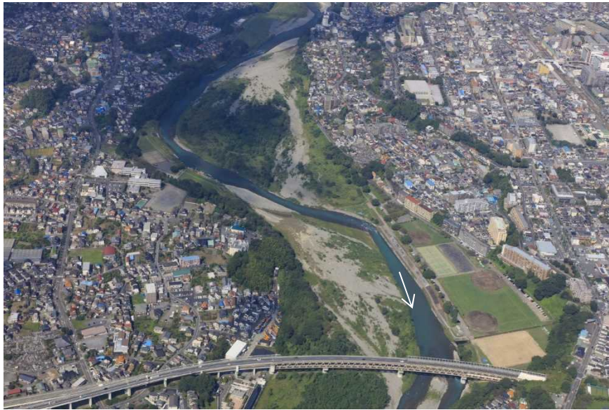
写真 2-7 扇頂部付近より上流の多摩川上流部（57.0k付近）（令和2年9月撮影）
