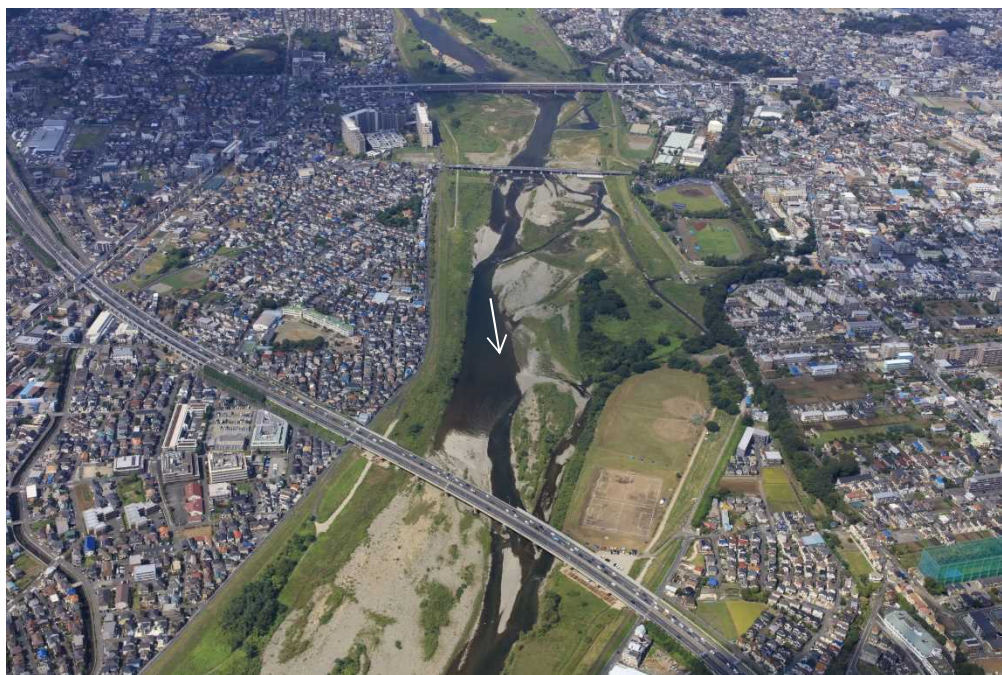
写真 2-9 交互砂州が広がる多摩川中上流部 (39.6k付近) (令和2年9月撮影)
