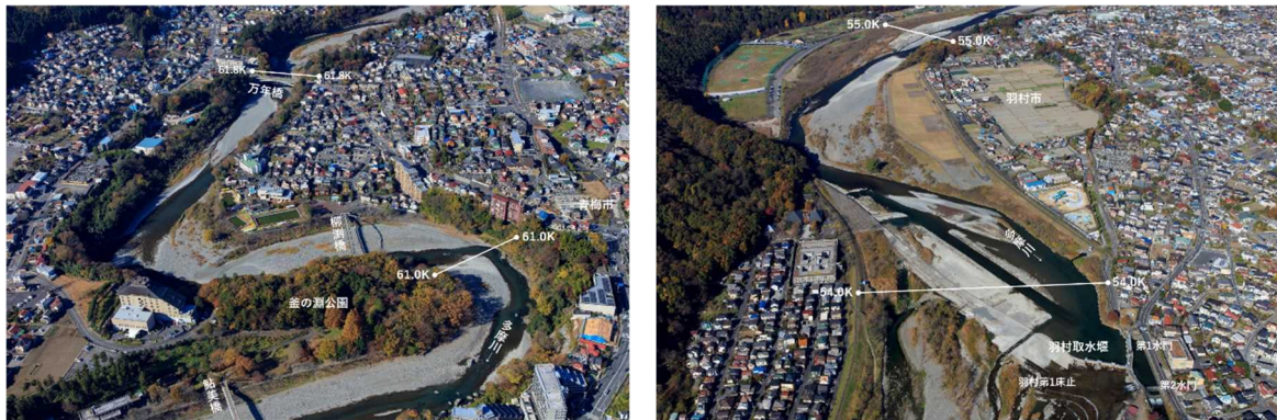
図 2-1 多摩川上流部の状況
