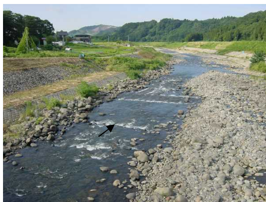
猿橋より下流を望む（妙高市）
