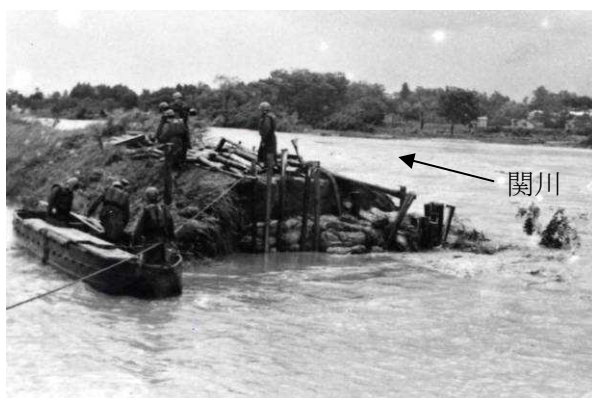
中央橋左岸堤防決壊状況
