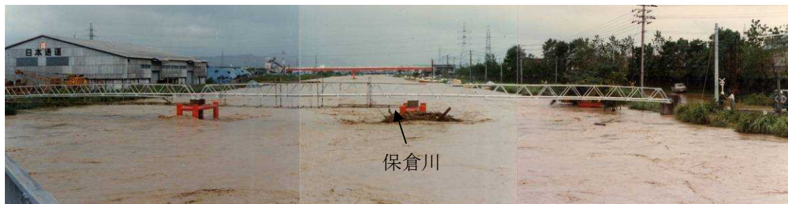
JR 信越本線保倉川橋梁より下流を望む
