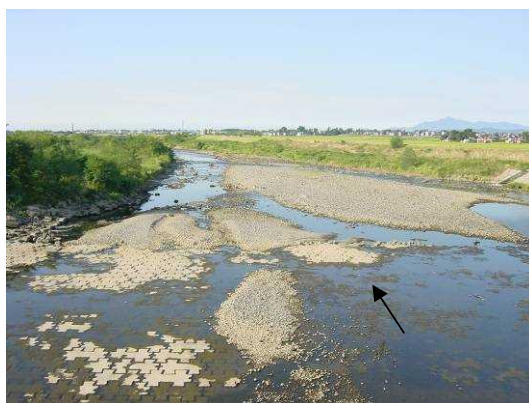
関川頭首工より下流を望む（妙高市）
