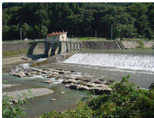
板倉発電所取水堰堤
