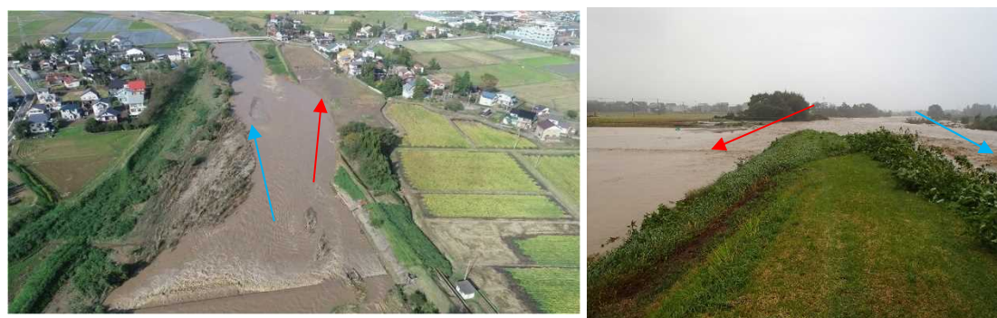
関川上流指定区間堤防決壊箇所（矢代川） 令和元年（2019 年）10 月 13 日午前 6 時 30 分
