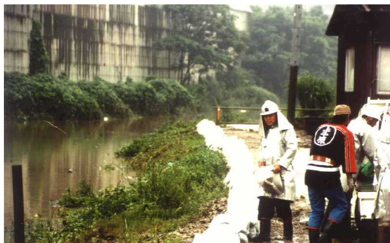
地元消防団による水防活動（積み土のう）の状況
