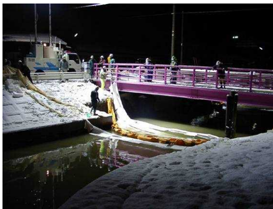
オイルフェンス設置状況
