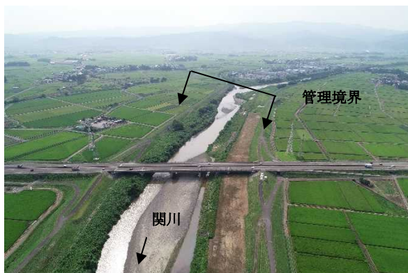
関川大臣管理区間上流端
