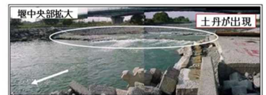
二ヶ領宿河原堰堤左岸側の本堤が決壊したため、堤内地を大きく迂回する濁流
