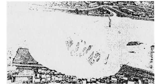
二ヶ領宿河原堰堤左岸側の本堤が決壊したため、堤内地を大きく迂回する濁流
