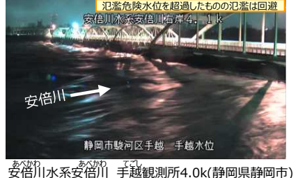
安倍川水系安倍川 手越観測所4.0k(静岡県静岡市)
