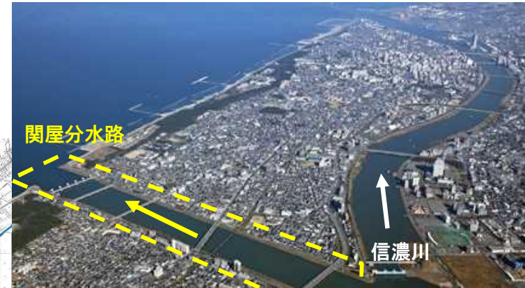
放水路事例(新潟県新潟市 関屋分水路)
