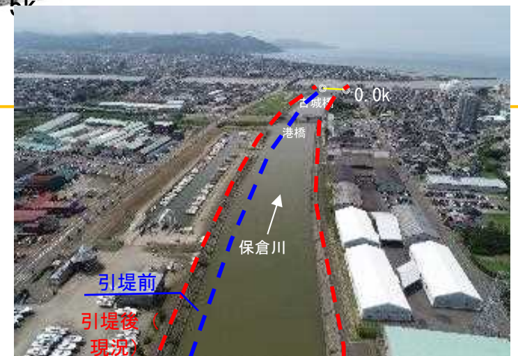
保倉川現況写真
