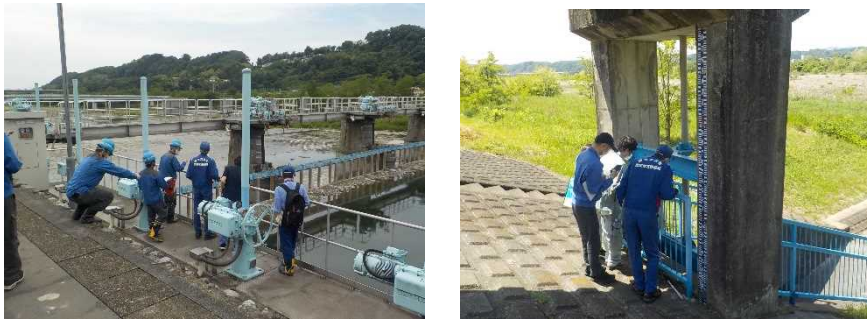
写真 9-1 現地検査状況
