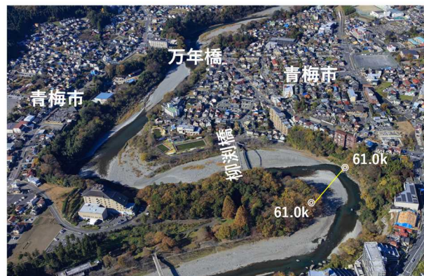
写真 8-2 上流部 61.0k付近
