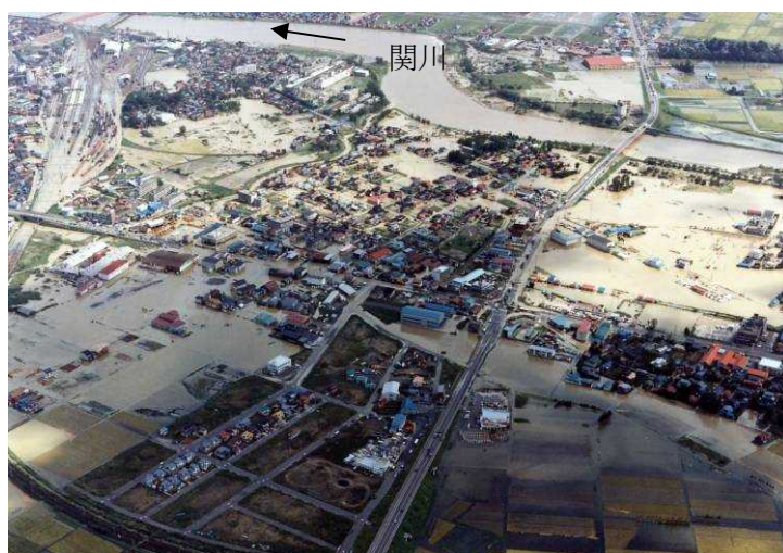
上空より関川大橋を望む
