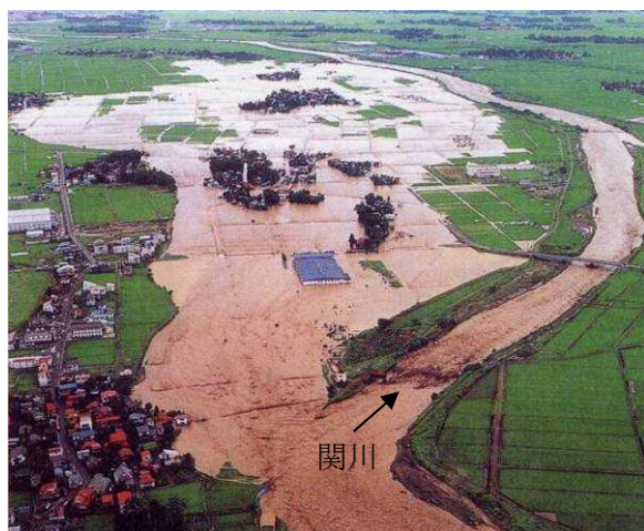
堤防決壊状況（妙高市月岡地先）
