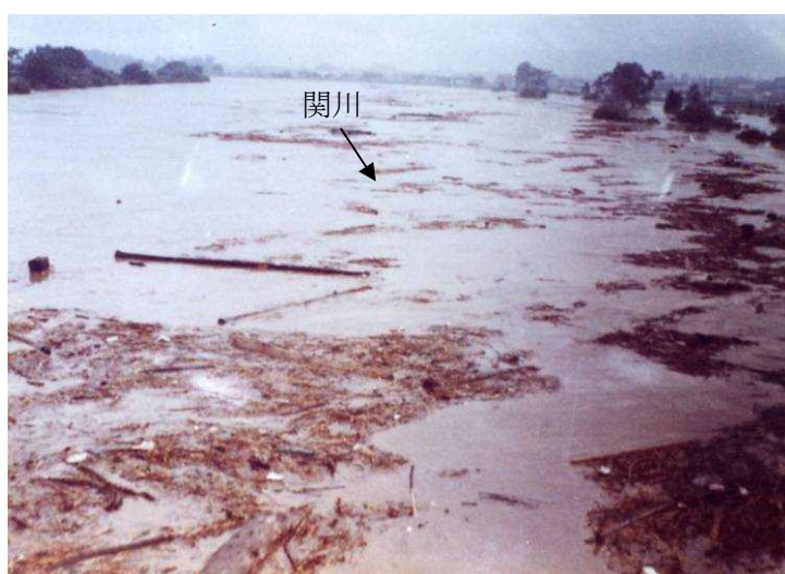
い いなだ 田橋上流洪水状況
