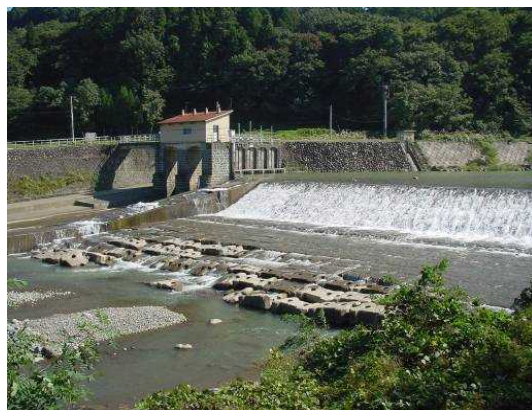
板倉発電所取水堰堤
