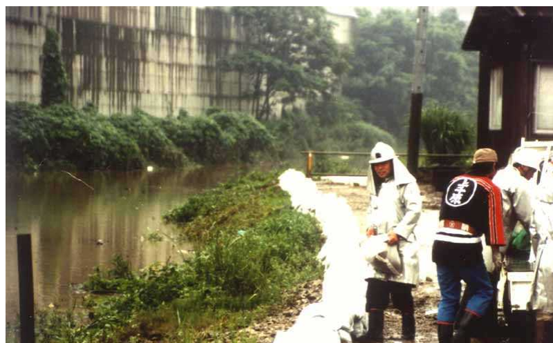
地元消防団による水防活動（積み土のう）の状況
