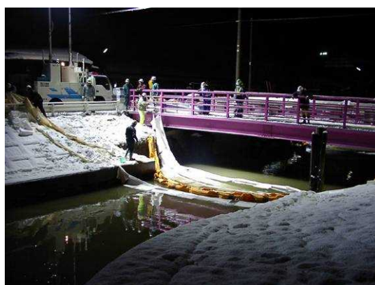
オイルフェンス設置状況
