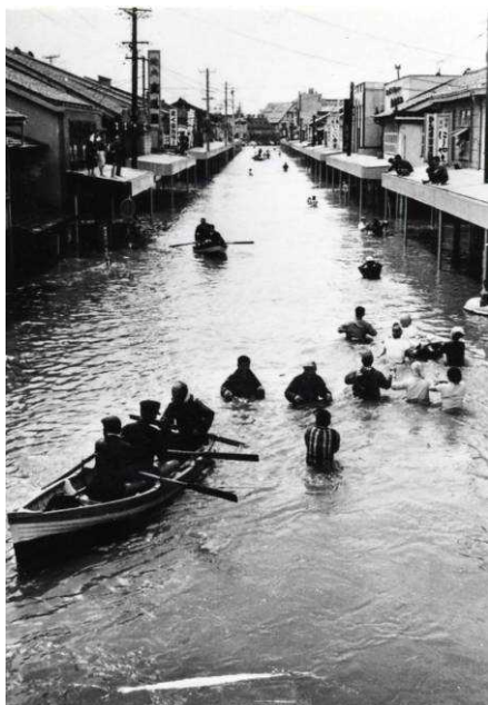
直江津駅前浸水状況
