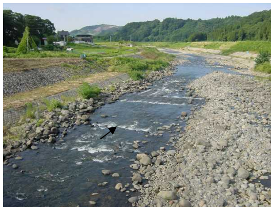
猿橋より下流を望む（妙高市）
