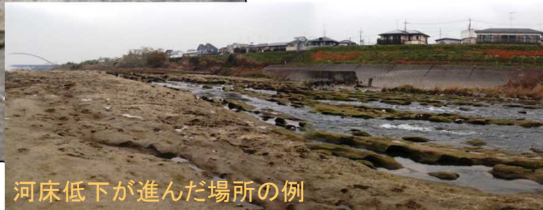
河床に露出している土丹
