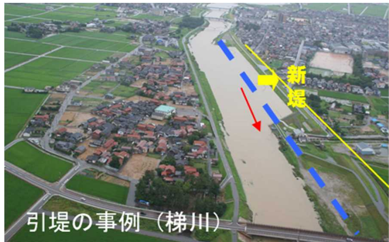
引堤の事例(梯川)
