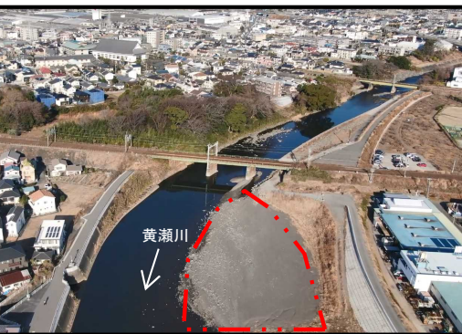
長泉町本宿地区 (河道掘削V=5.0千m³)
