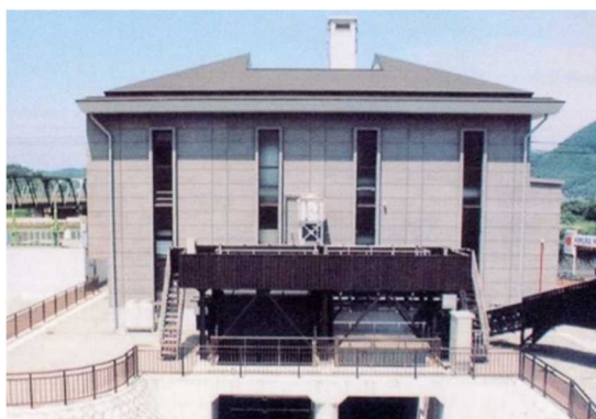
四日町排水機場
