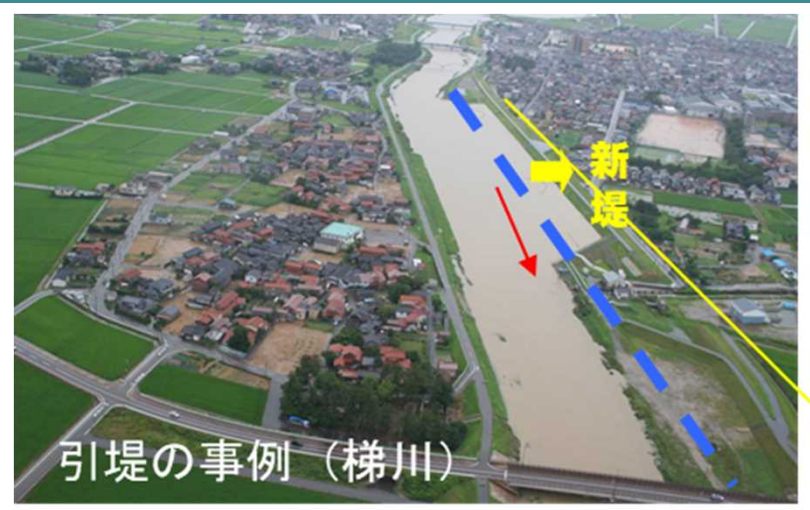
引堤の事例(梯川)
