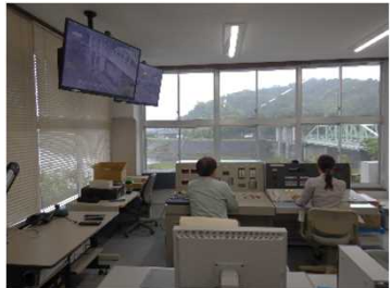
分流堰 操作状況
