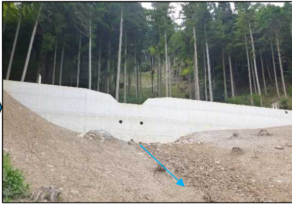
R2実施 治山ダム
