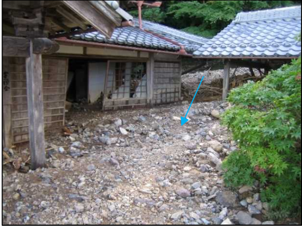
平成26年豪雨時 被災状況
