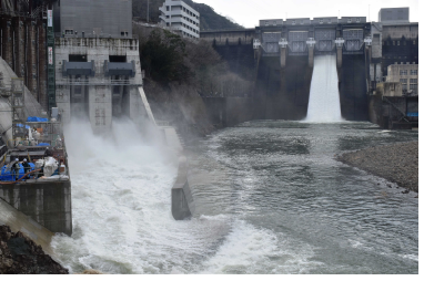
トンネル洪水吐完成後
