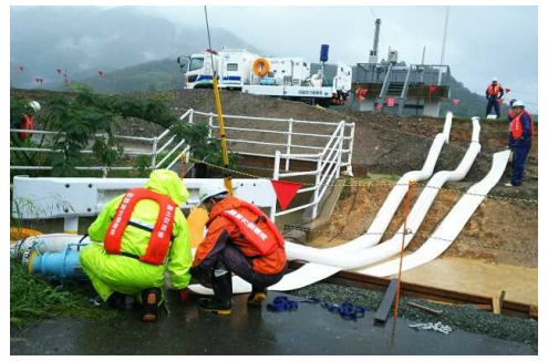
西大洲第2樋門での排水状況 (H30. 7豪雨による被害発生時)
