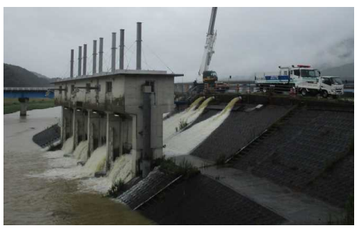
都谷川排水樋門での排水状況 (H30. 7豪雨による被害発生時)
