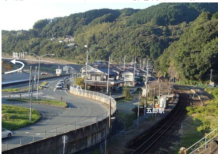
五郎地区（宅地かさ上げ方式改修後）
