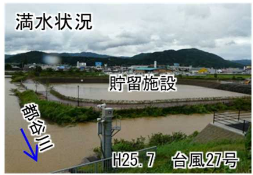
貯留施設状況
