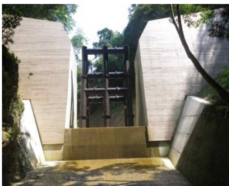
【県】大谷川 鋼製透過型堰堤
