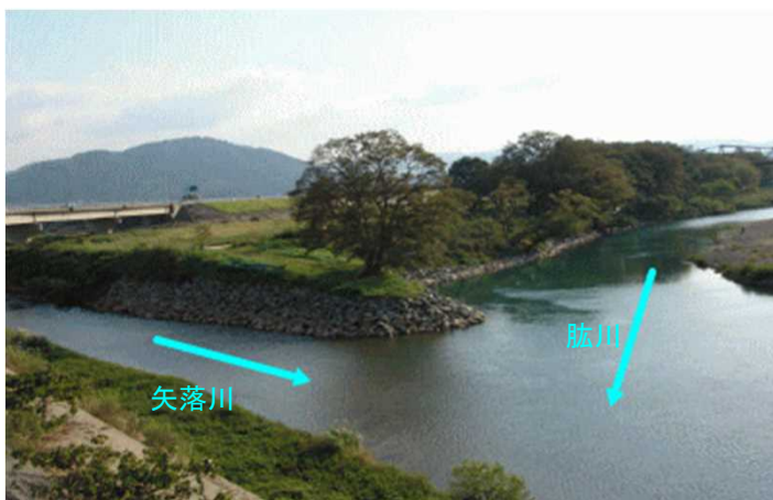
施工後（1年半経過）
