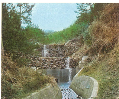
【国】長谷川一号堰堤
