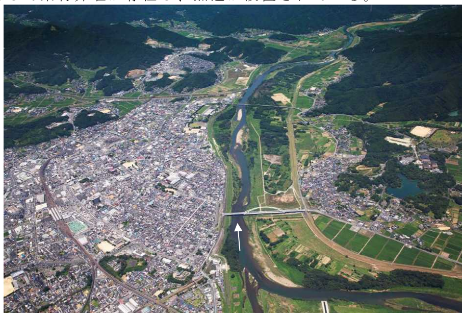
写真 2-9 河畔林と瀬・淵の特徴的な由良川中流部（37.0k付近）（令和3年7月撮影）
