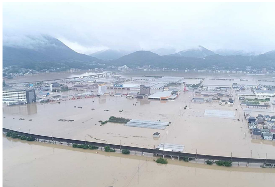
平成 30 年（2018 年）7 月（梅雨前線） 東大洲地区浸水状況
