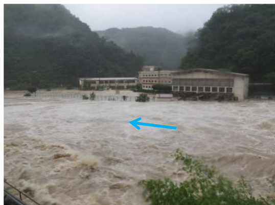
平成 30 年（2018 年）7 月（梅雨前線） 大洲市肱川町 出典：大洲河川国道事務所
