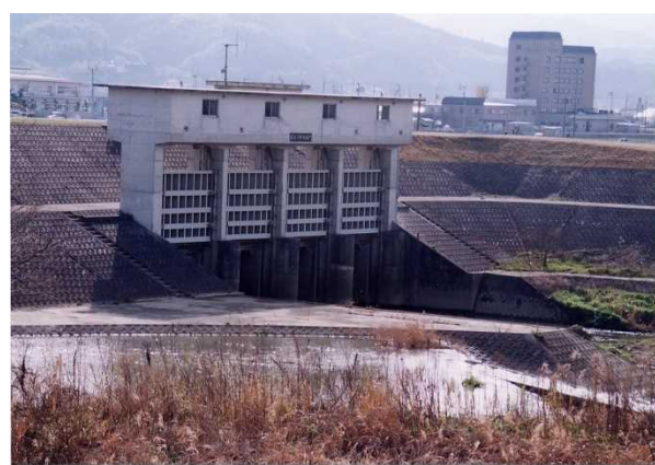
写真 9.2 都谷川排水樋門(矢落川 0.8k 左岸)
