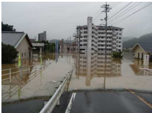
平成 30 年（2018 年）7 月（梅雨前線） 西大洲地区（7 日 15 時頃） 出典：大洲河川国道事務所
