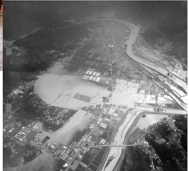
昭和 57 年（1982 年）8 月洪水 矢落川上流からみた大洲盆地
