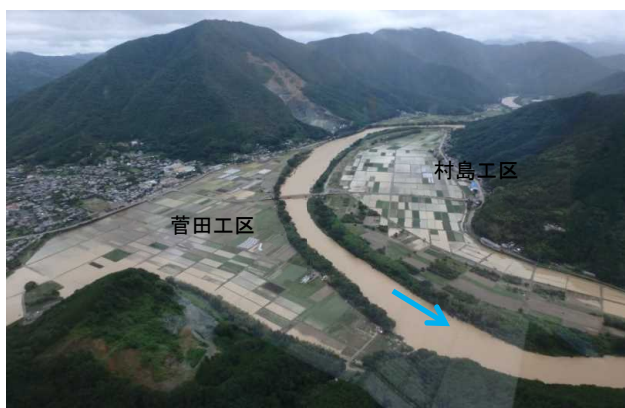
平成 30 年（2018 年）7 月（梅雨前線） 菅田地区（8 日 12 時頃） 出典：大洲河川国道事務所
