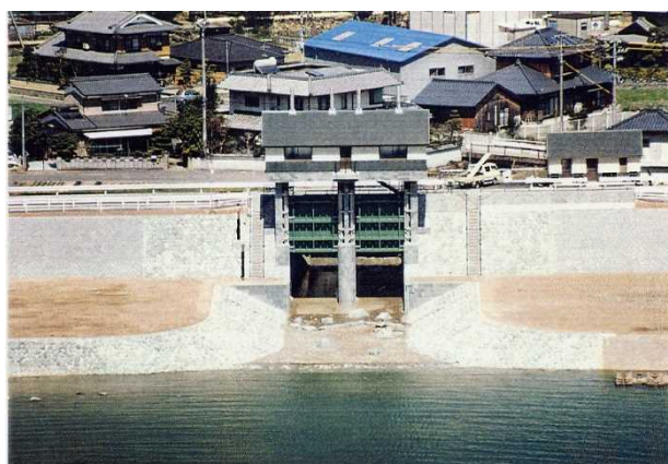
写真 9.1 田淵樋門(肱川 5.4k 右岸)
