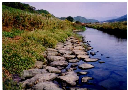
写真 8.1(3) 矢落川多自然護岸施工 (1.4~1.6k 右岸)
