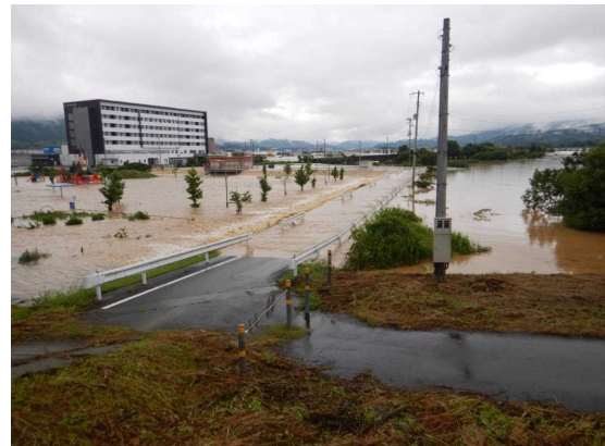
平成 30 年（2018 年）7 月（梅雨前線） 東大洲地区の二線堤越流状況
