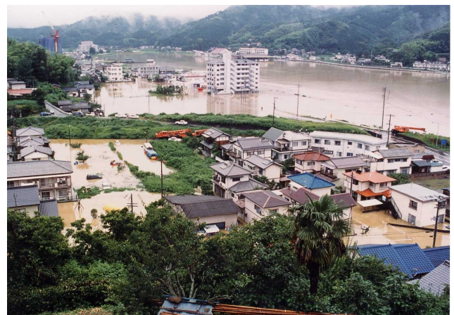
平成 7 年（1995 年）7 月洪水 支川久米川の氾濫状況
