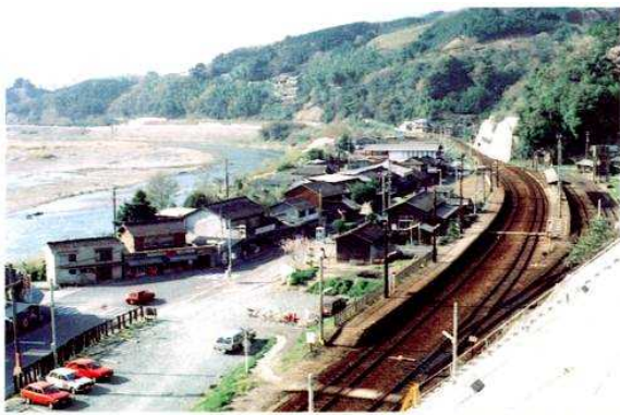
五郎駅前地区施工前(上流より)
