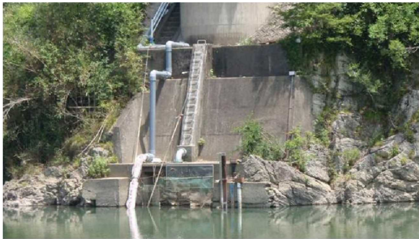
図 4.2 平成 21 年の夏渇水による水位低下時の取水塔の状況
