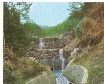
【国】長谷川一号堰堤
