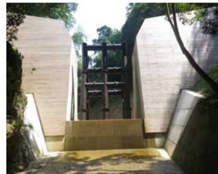
【県】大谷川 鋼製透過型堰堤
