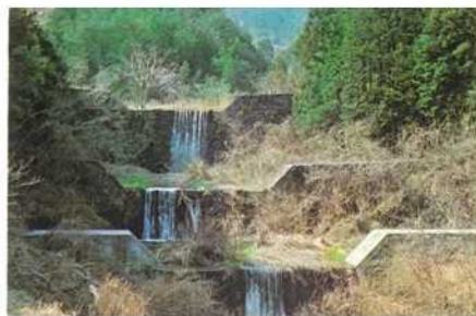
【国】久米川一号堰堤
