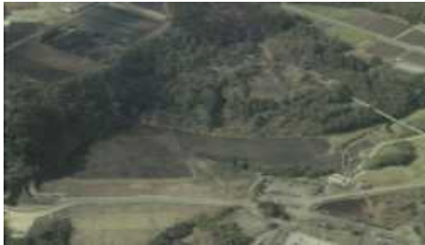
高鍋防災ダム
