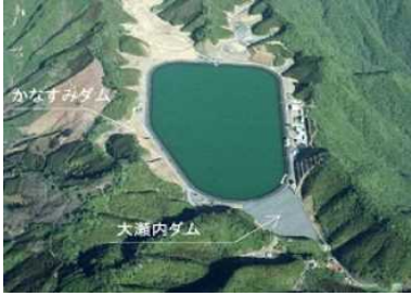
大瀬内・かなすみダム
