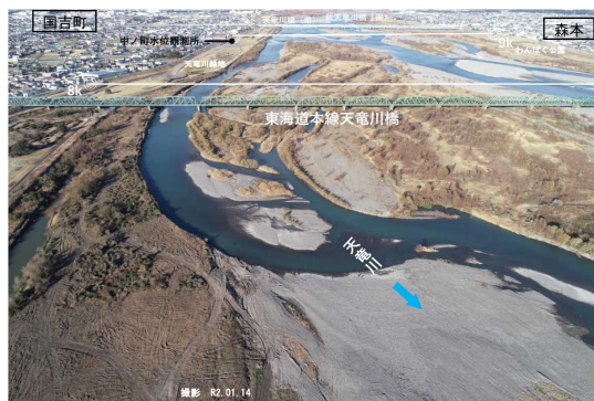
東海道線下流部付近の状況
