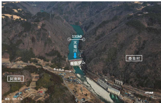
泰阜ダム付近の状況
