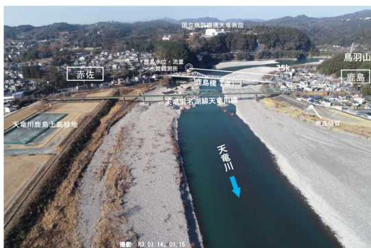
鹿島地点の状況
