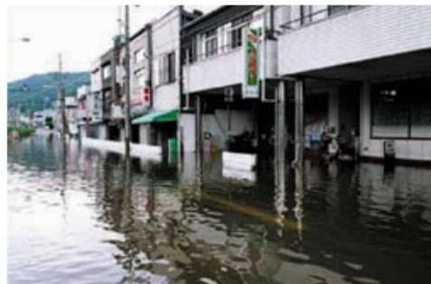
諏訪市内の浸水状況
