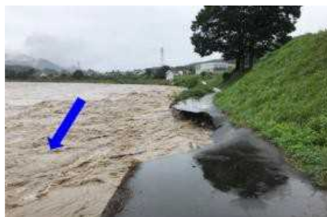
天竜川左岸 208.2k 付近 河岸侵食
