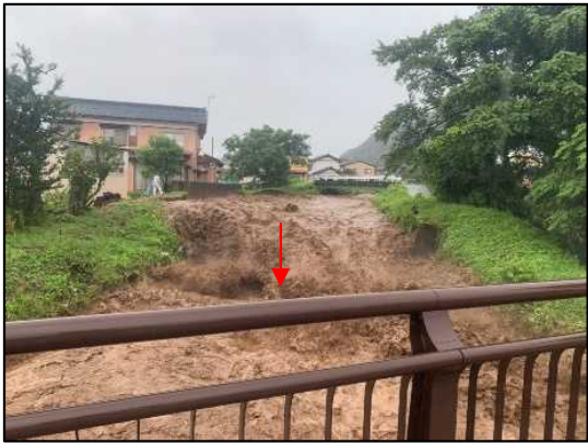
九頭竜川水系 暮見川 護岸損壊(勝山市郡町3丁目)
