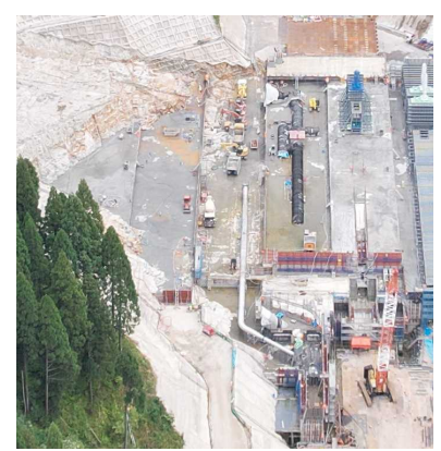
ダム本体(コンクリート打設状況)
