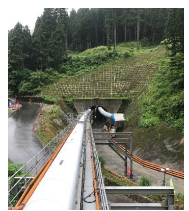
水海川導水トンネル(整備中)
