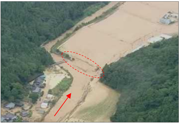
九頭竜川水系 鹿蒜川 破堤箇所(南越前町南今庄)
