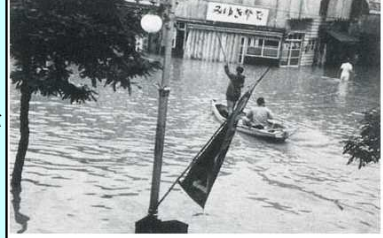
福井市城の橋通りの浸水状況
