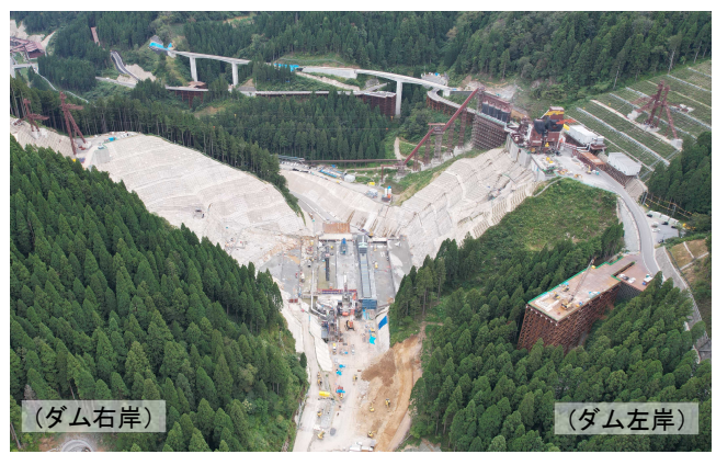
ダム本体(整備中)
