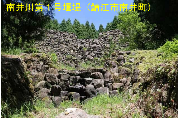
砂防堰堤では、洪水時に発生した土石流を受け止め、下流への被害を未然に防いでいる。
