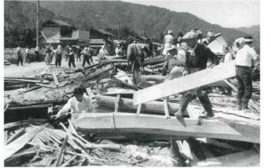
上志比村(現永平寺町)の被災状況
