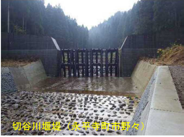
砂防堰堤では、洪水時に発生した土石流を受け止め、下流への被害を未然に防いでいる。
