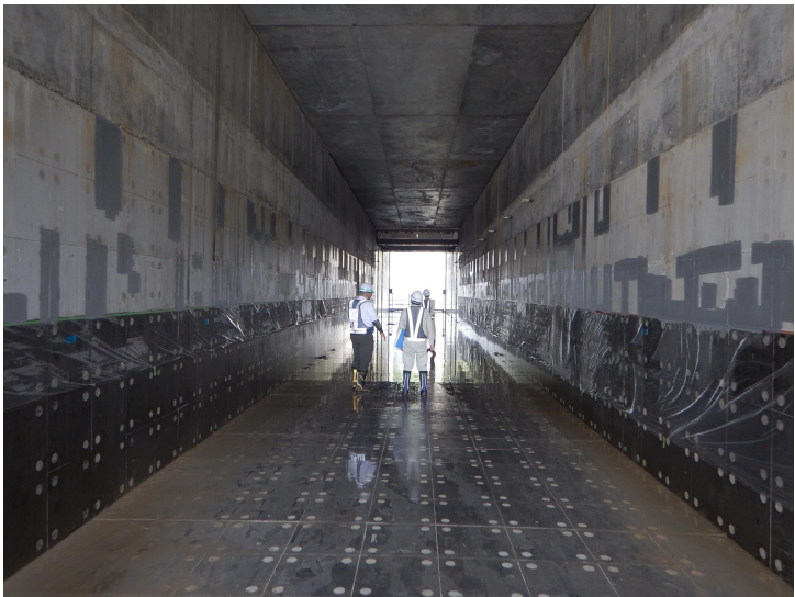
融雪期用放流設備ライニングステンレスライニング
