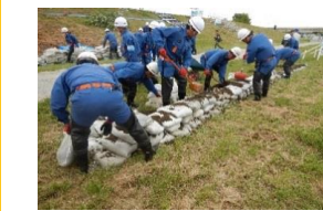
防災機関による積み土のう工
