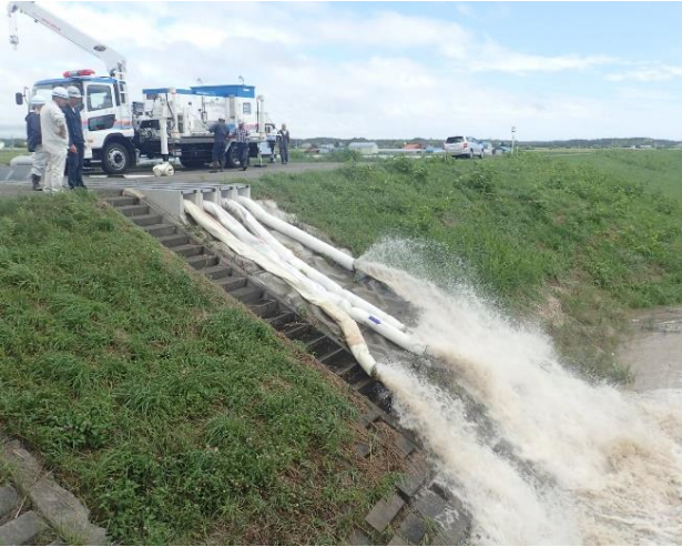
排水ポンプ車活動状況 (平成28年)
