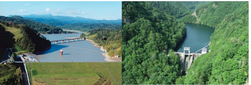
穂別ダム 双珠別ダム
