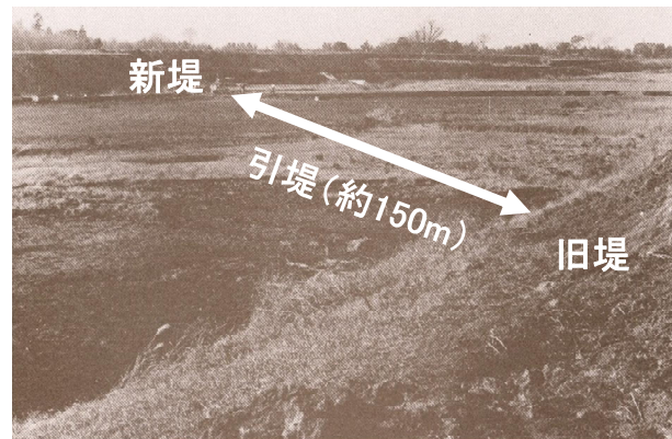
江戸川右岸47.0km付近での引堤状況(昭和28年12月) ※手前は旧堤
