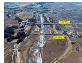
福岡堰付近(約27km)
