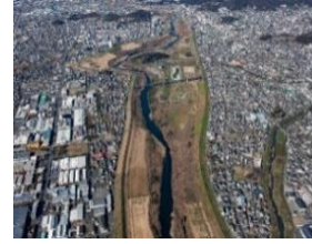
岩井分水路地点(約33km)
