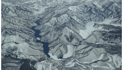
矢木沢ダム・奈良俣ダム
