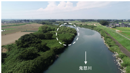
掘削工事实施前
