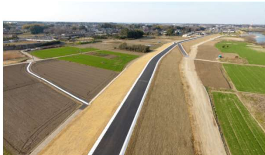
常総市坂手地区堤防整備状況
