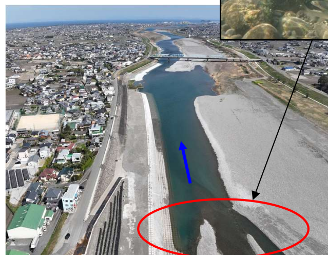
施工後 (No. 3付近)
