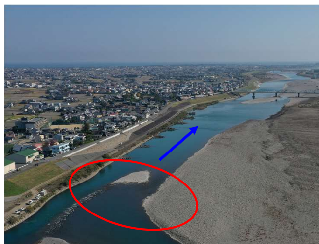
施工前 (No. 3付近)
