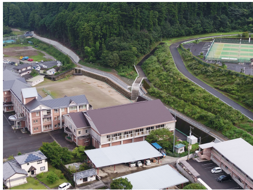
南川排水路整備
