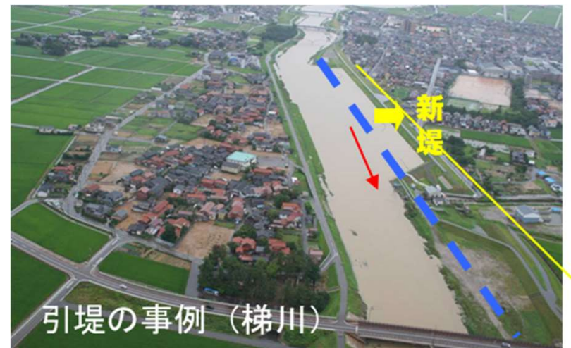
引堤の事例(梯川)
