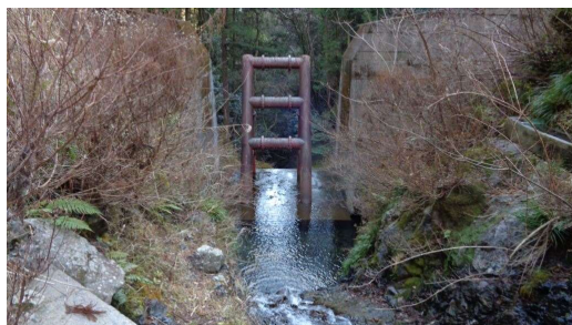
東谷川砂防堰堤 平成 24 年（2012 年）完成
