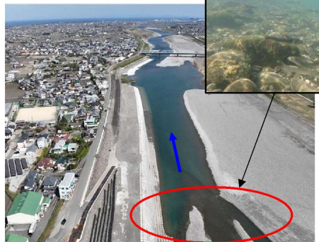
施工後 (No. 3付近)
