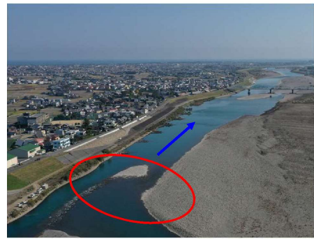
施工前 (No. 3付近)
